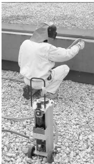
Der ehemalige Kanzlerbungalow in Bonn erstrahlt in neuem Glanz – die auffällige Metall-Attika, die über rund 150 Meter als Dachabschluss umläuft, hat der Koblenzer Malerbetrieb Würzberger entrostet und neu beschichtet. Am Sandstrahlgerät arbeitete Viktor, ein Russe – die Mitarbeiter von Maler Würzberger haben ihre Wurzeln in 13 verschiedenen Nationen.
