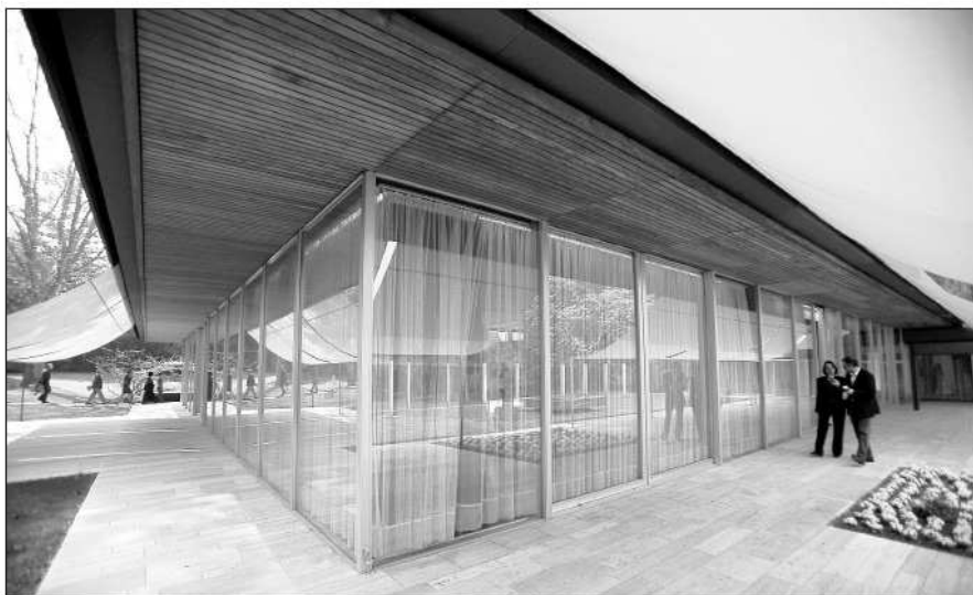
Der ehemalige Kanzlerbungalow in Bonn erstrahlt in neuem Glanz – die auffällige Metall-Attika, die über rund 150 Meter als Dachabschluss umläuft, hat der Koblenzer Malerbetrieb Würzberger entrostet und neu beschichtet. Am Sandstrahlgerät arbeitete Viktor, ein Russe – die Mitarbeiter von Maler Würzberger haben ihre Wurzeln in 13 verschiedenen Nationen.
